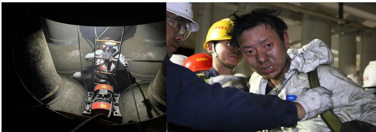
伴随着初冬的刺骨寒风，奋斗者在变换区域将催化剂一包包倒至塔内，并一次又一次全副武装进入塔内，将塔内催化剂全部铺平。不知在黑暗里进行了多少次轮换，眼力、毅力、执行力，从白天干到黑夜，一道道工序的顺利开展，一声声激昂的奋斗呐喊，全力保障了变换催化剂更换任务圆满完成。
